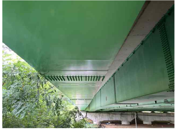
거더내부 S2 상태양호
