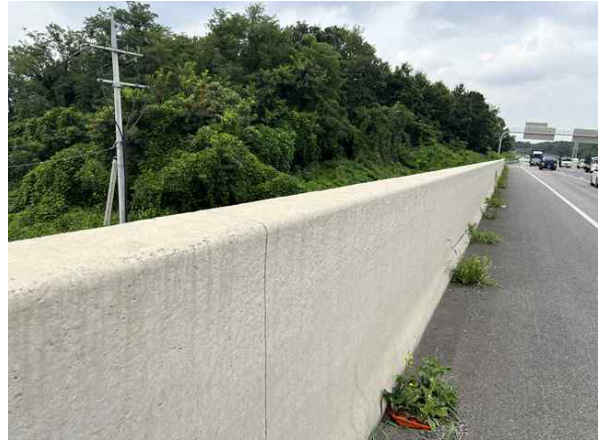
방호벽 S2 상태양호
