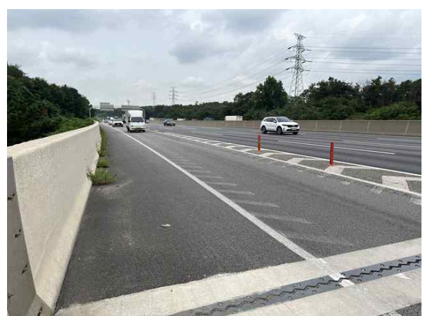
교면포장 S2 상태양호
