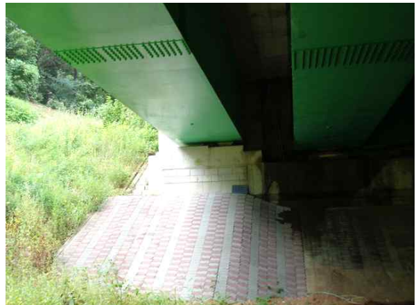
교대 A1 상태양호
