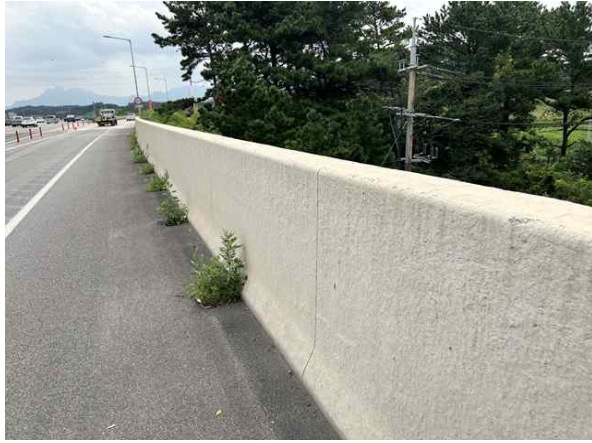
방호벽 S1 상태양호
