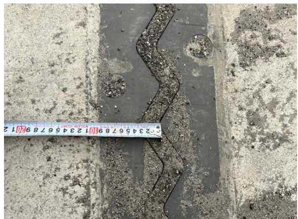
신축이음 이동량 측정
