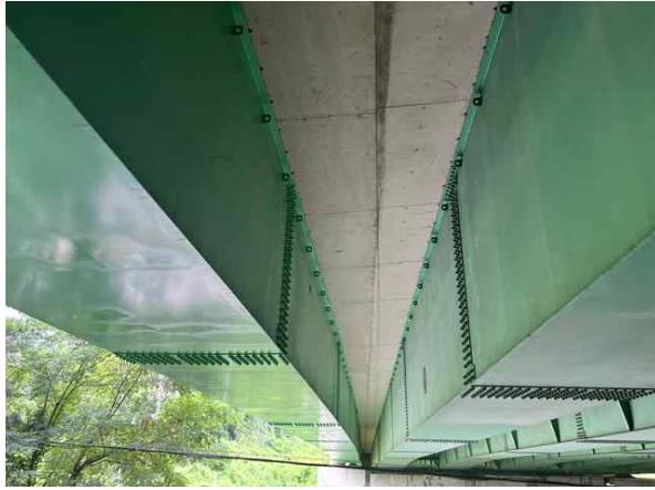
바닥판 하면 S2 상태양호
