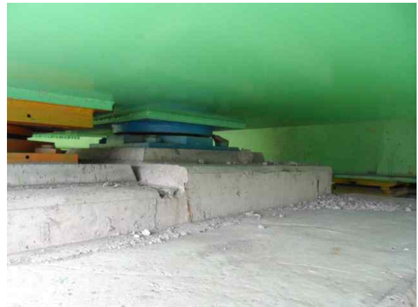
교량받침 P1-Sh1 상태양호
