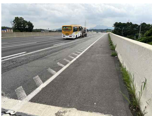
교면포장 S1 상태양호
