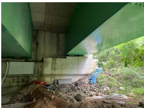
교대 A2 상태양호
