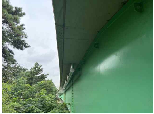
바닥판 하면 S2 상태양호
