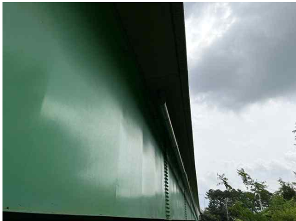
바닥판 하면 S1 상태양호
