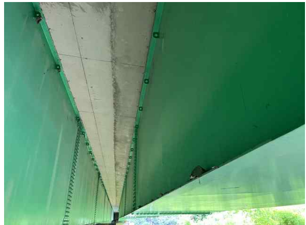
바닥판 하면 S1 상태양호
