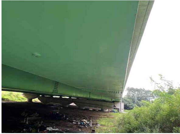
거더내부 S1 상태양호
